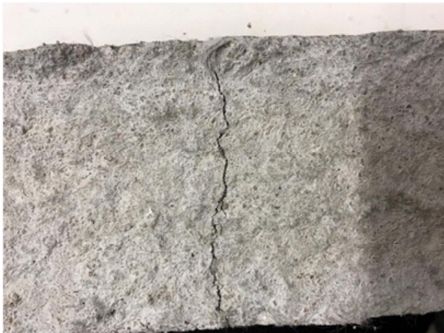
Figura 4. Corpos de prova em detalhe com fissuras em estágio inicial
